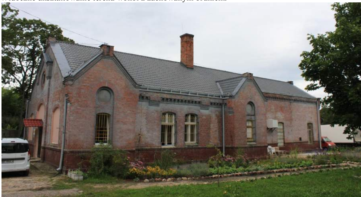
Fot.nr 2. Kuźnia ul. Monte Cassino 4, Olsztyn. Koszary Artylerii wybudowane w I fazie 1888-1889. Elewacja południowo-wschodnia. Widoczne zniszczenia elewacji spowodowane przemalowaniem farbami emulsyjnymi. Ubytki spoinowania w parapetach i cokole spowodowane wpływem znacznego zawilgocenia dolnych partii budynku. Zamurowanie wąskich otworów okiennych w części ściany pomiędzy ryzalitami. Widoczne wtórne stolarki okienne wprowadzane przypadkowo w obiekt tzw.systemem gospodarczym. Okulusy w ryzalitach zamurowane i otynkowane silną zaprawą cementową, scalone na szary kolor. Widoczna nadmurowana korona powstała w trakcie zmiany konstrukcji i kształtu dachu. Wzdłuż elewacji cementowa opaska przechodząca w betonową szeroką
