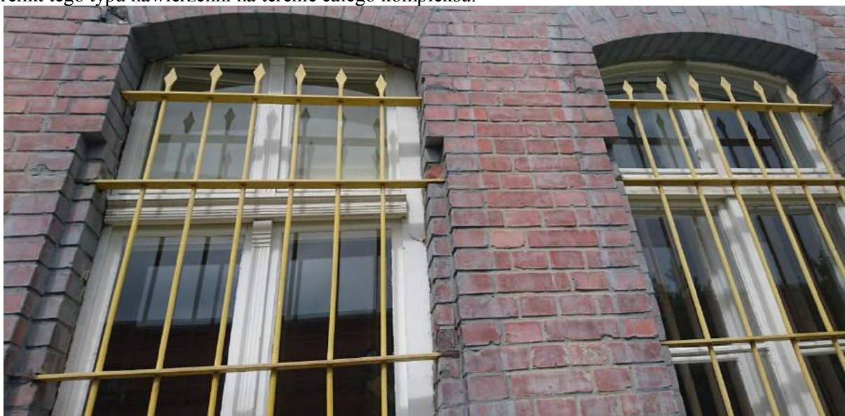
Fot.nr 4. Kuźnia ul. Monte Cassino 4, Olsztyn. Koszary Artylerii wybudowane w I fazie 1888-1889. Elewacja południowo-wschodnia. Widoczne wprowadzone w obiekt wtórne drewniane stolarki okienne z warstwami bieli, świadczą o powojennym ich zamontowaniu. Kraty także zamontowano współcześnie. Na powierzchni wątku ceglanego widoczne zacieki farb zastosowanych do „odświeżenia” elewacji poprzez pomalowanie obramień okiennych w tzw. opaski.
