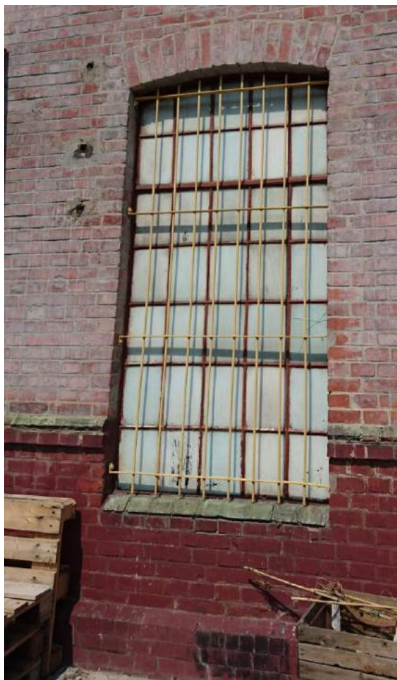
Fot. Nr 41 i 42 Kuźnia ul. Monte Cassino 4, Olsztyn. Koszary Artylerii wybudowane w I fazie 1888-1889. Elewacja południowo-wschodnia przekształcone otwory okienne, ślusarki oryginalne z II fazy budowlanej koszar.
