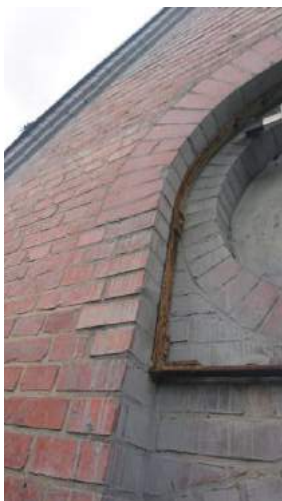
Fot.nr 9 i 10. Kuźnia ul. Monte Cassino 4, Olsztyn. Koszary Artylerii wybudowane w I fazie 1888-1889. Elewacja południowo-wschodnia. Fragment zachowanej ślusarki ramy osłaniającej otwór okulusa wentylującego i doświetlającego zarazem poddasze budynku. Pierwotnie we wszystkich okulusach ścian bocznych były szklane oprawy otworów.
