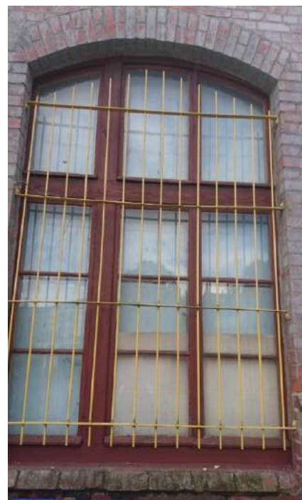
Fot.nr 6 i 7. Kuźnia ul. Monte Cassino 4, Olsztyn. Koszary Artylerii wybudowane w I fazie 1888-1889. Elewacja południowo-wschodnia. Przekształcone otwory okienne oraz wtórne stolarki okienne i historyczna ślusarka z II fazy budowlanej koszar z lat 1899-1902 z widocznym w samoistnych odkrywkach oryginalnym szarym kolorze.
