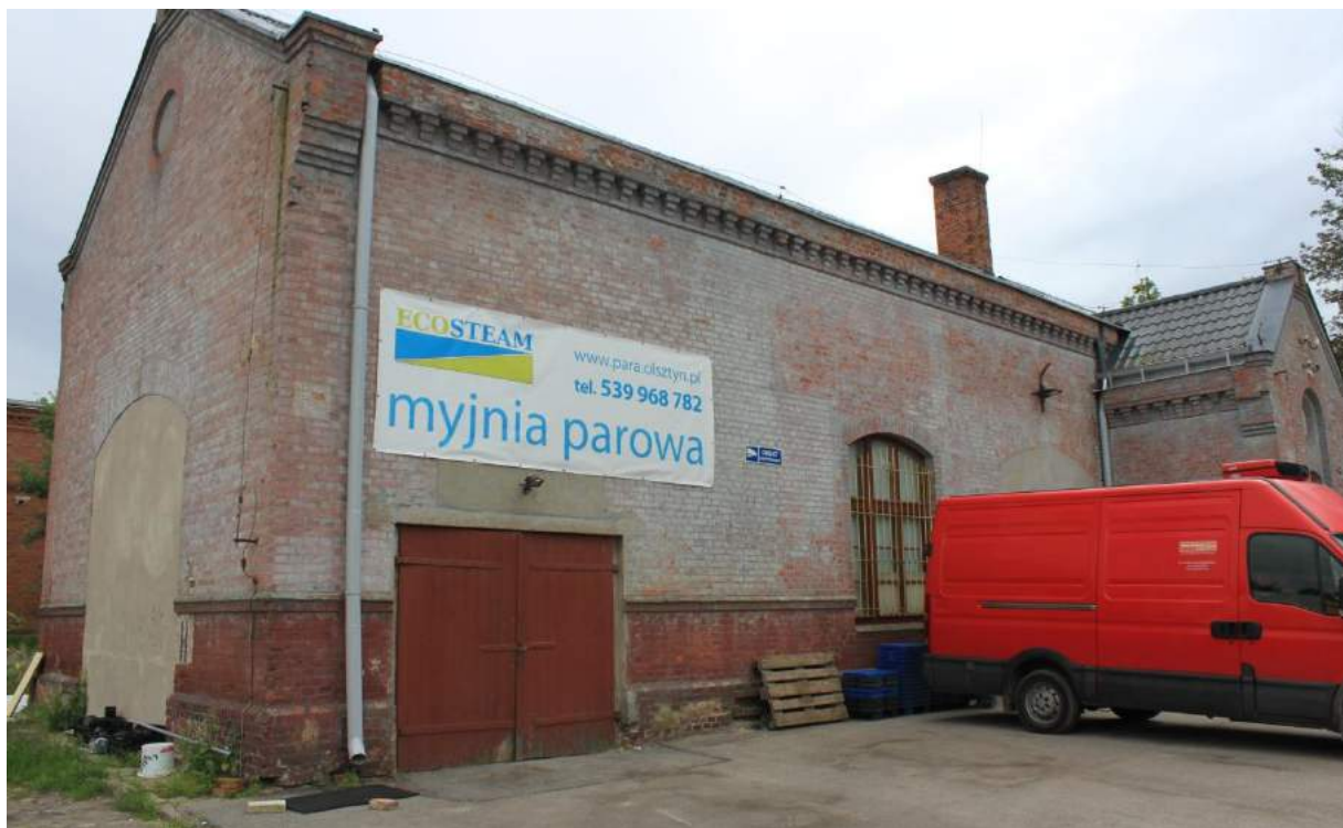
Fot. nr 13. Kuźnia ul. Monte Cassino 4, Olsztyn. Koszary Artylerii wybudowane w I fazie 1888-1889. Elewacja północno-zachodnia część północna. Widoczne przemurowania i współczesna aranżacja ściany poprzez zamurowanie otworu okiennego i wstawienie bramy. Obok przekształcony otwór okienny ze współczesną wtórną stolarką. Nawierzchnia betonowa nieprzepuszczalna i szkodliwa dla ścian budynku.
