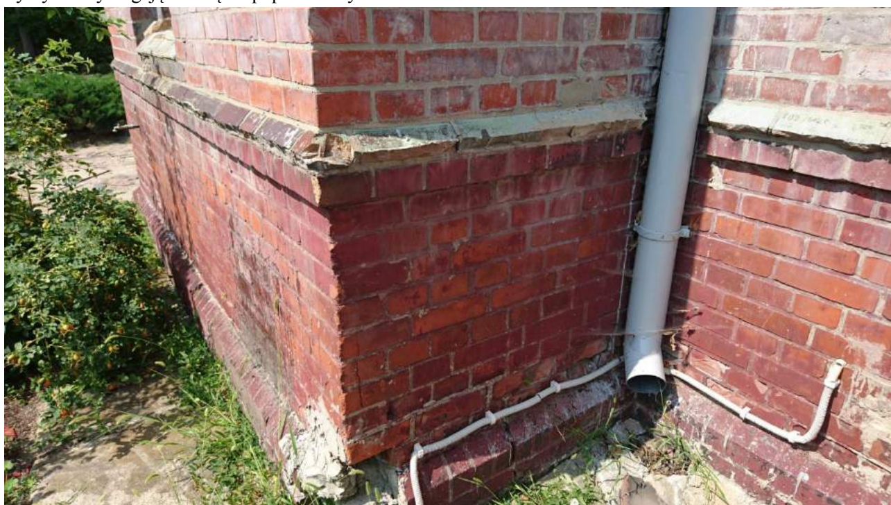
Fot. nr 20. Kuźnia ul. Monte Cassino 4, Olsztyn. Koszary Artylerii wybudowane w I fazie 1888-1889. Elewacja południowo-wschodnia. Widoczny cokół z cegły glazurowanej licowej klinkierowej uzupełnionej przypadkowymi ceglami a następnie pomalowany na czerwono, całkowicie zniekształcony odbiór estetyczny wątku. Zniszczenia i utracenia narożników i kapinosów. Ubytki cegieł w strefie przemarzania cokołu fundamentowego stale zawilgoconego. Przypadkowe instalacje elektryczne oraz nawierzchnia betonowa wymagająca korekty spadków i rozszczelnienia.
