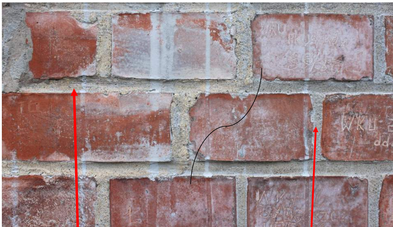
Fot. nr 31. Kuźnia ul. Monte Cassino 4, Olsztyn. Koszary Artylerii wybudowane w I fazie 1888-1889. Elewacja południowo-wschodnia.
