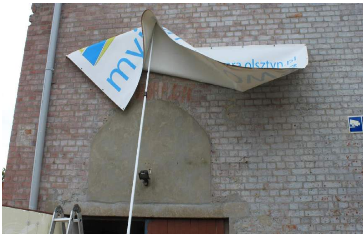
Fot. nr 15. Kuźnia ul. Monte Cassino 4, Olsztyn. Koszary Artylerii wybudowane w I fazie 1888-1889. Elewacja północno-zachodnia. Część północna elewacji, widoczne zamurowane wąskie okno najprawdopodobniej współczesnej aranżacji powojennej w miejscu dawnego większego otworu okiennego oraz wprowadzona w te zmiany kolejna aranżacja ze współczesną bramą wjazdową do wnętrza budynku. Wątek zamalowany szarą farbą emulsyjną zakrywa miejscowe przemurowania i naprawy.
