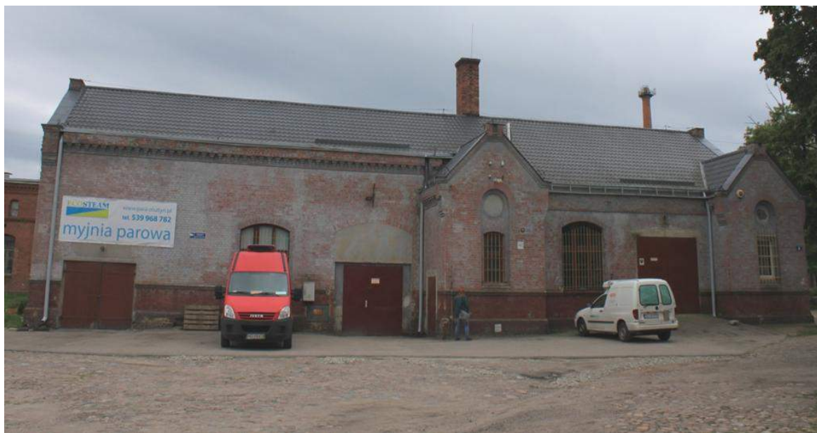
Fot. nr 14. Kuźnia ul. Monte Cassino 4, Olsztyn. Koszary Artylerii wybudowane w I fazie 1888-1889. Elewacja północno-zachodnia. Widok ogólny stanu przed konserwacją. Najbardziej przekształcona i zniszczona elewacja. Na powierzchni wątku ceglanego warstwy farb, m.in. szarej emulsyjnej wymagającej zmycia. Betonowa nawierzchnia z pozostałościami historycznej brukowanej nawierzchni.
