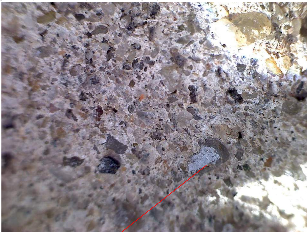
Fot. Nr. 40. Kuźnia ul. Monte Cassino 4, Olsztyn. Koszary Artylerii wybudowane w I fazie 1888-1889. Elewacja północno-zachodnia przekształcone wejście wjazdu bocznego do kuźni. Zmniejszone światło wjazdu, tynk pokrywający zamurowanie, fotografia makroskopowa, Zaprawa wtórna wapienno-cementowa, widoczna mała ilość spoiwa wapiennego i zróżnicowany skład wypełniacza oraz szara przemalówka na powierzchni tynku.
