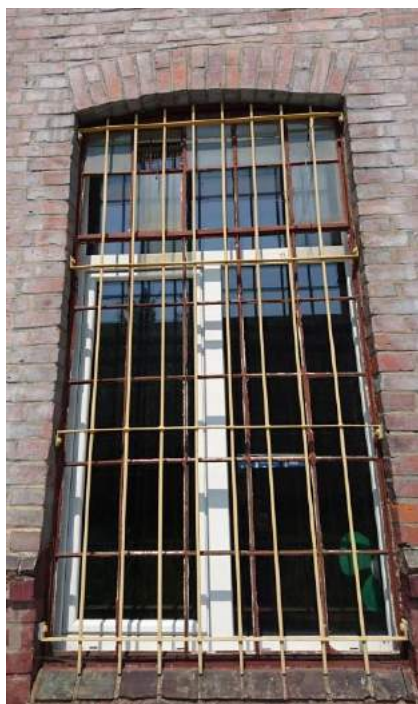
Fot.nr 6 i 7. Kuźnia ul. Monte Cassino 4, Olsztyn. Koszary Artylerii wybudowane w I fazie 1888-1889. Elewacja południowo-wschodnia. Przekształcone otwory okienne oraz wtórne stolarki okienne i historyczna ślusarka z II fazy budowlanej koszar z lat 1899-1902 z widocznym w samoistnych odkrywkach oryginalnym szarym kolorze.
