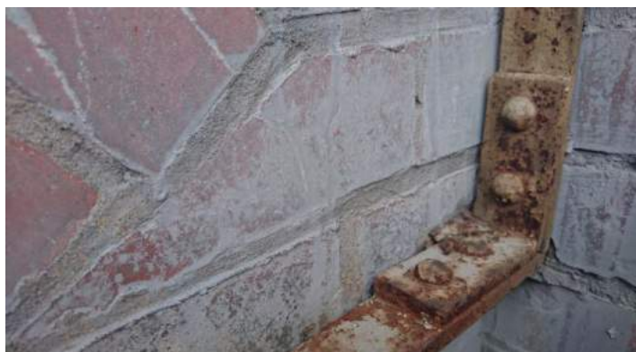
Fot.nr 9 i 10. Kuźnia ul. Monte Cassino 4, Olsztyn. Koszary Artylerii wybudowane w I fazie 1888-1889. Elewacja południowo-wschodnia. Fragment zachowanej ślusarki ramy osłaniającej otwór okulusa wentylującego i doświetlającego zarazem poddasze budynku. Pierwotnie we wszystkich okulusach ścian bocznych były szklane oprawy otworów.
