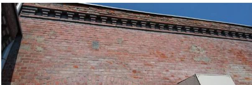
Fot.nr 4. Kuźnia ul. Monte Cassino 4, Olsztyn. Koszary Artylerii wybudowane w I fazie 1888-1889. Elewacja południowo-wschodnia. Widoczne wprowadzone w obiekt wtórne drewniane stolarki okienne z warstwami bieli, świadczą o powojennym ich zamontowaniu. Kraty także zamontowano współcześnie. Na powierzchni wątku ceglanego widoczne zacieki farb zastosowanych do „odświeżenia” elewacji poprzez pomalowanie obramień okiennych w tzw. opaski.
